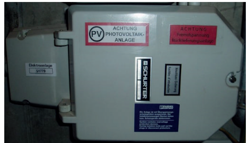
Beschriftungen Hausanschlusskasten
